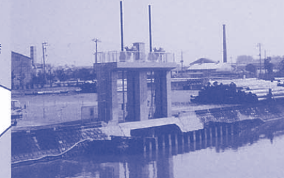
岳南排水路吐口(沼川吐口) 田子の浦港内に2ヶ所ある吐口の一つ(平成8年2月新設)
