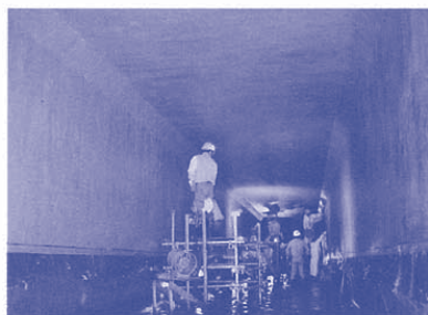
岳南5号排水路函きょ補修工事状況(ライニング) □3,000mm×3,000mm
