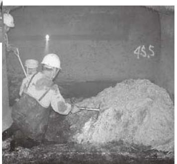
管内に堆積した土砂等の浚渫作業
