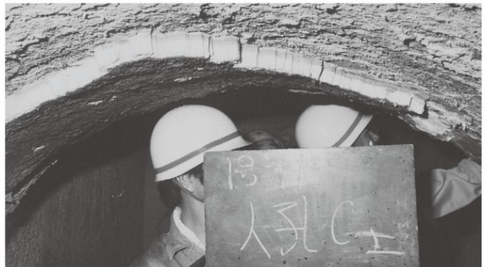
硫化水素により腐食した管渠(昭和49年頃)
