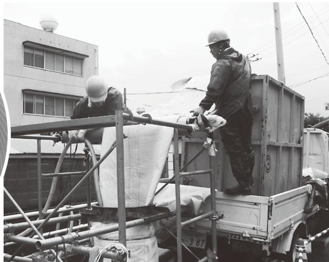
反転工法(ICP工法)による管渠更生工事 [熱硬化性樹脂を含ませたライナーを管内に反転挿入]
