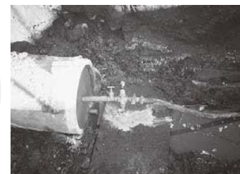
廃止管にモルタルを充填
