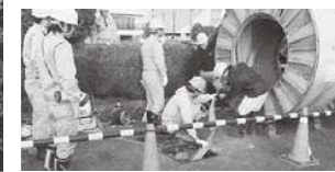
更生材を人孔から挿入
