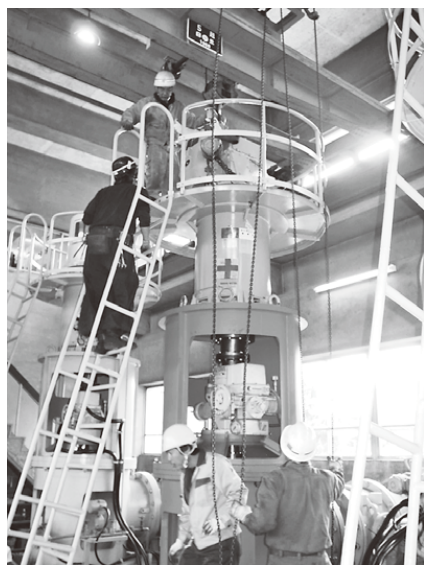
主モーターの取付作業
