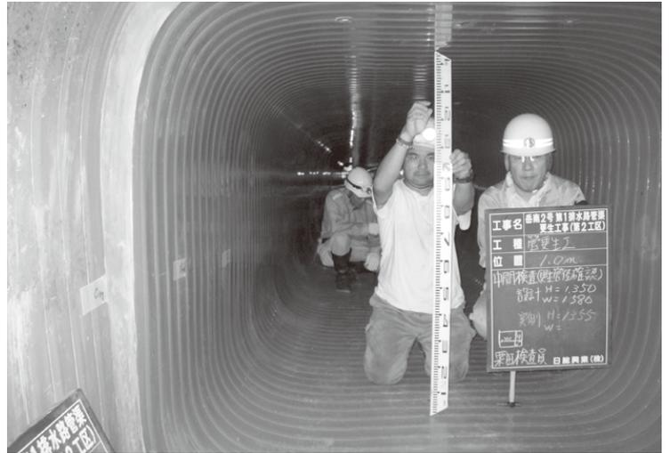
更生工事(製管工法:SPR工法)施工後
