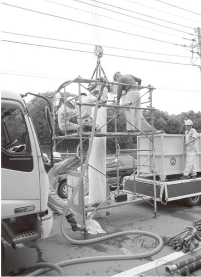
反転工法(ICPブリース工法)による管渠更生工事
