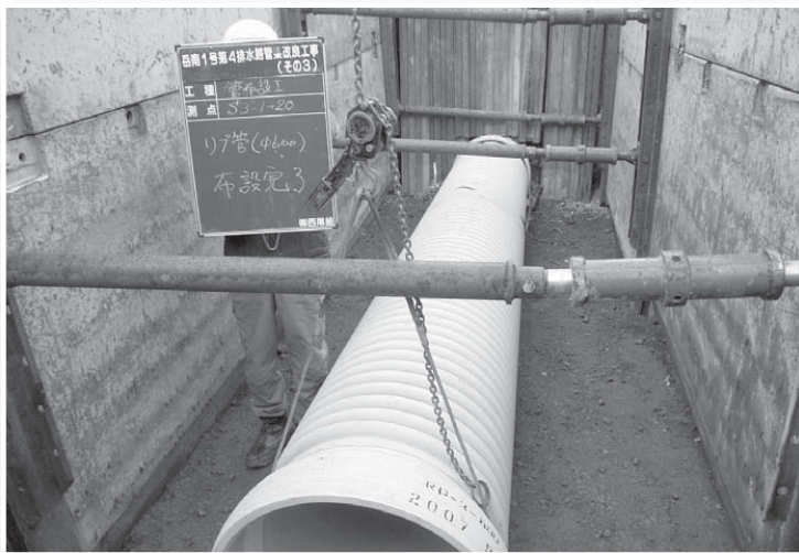
ポリエチレン管布設
