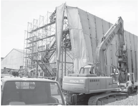
旧庁舎解体工事
