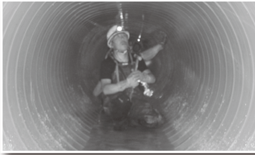
製管工法による管渠更生工事(3号第4排水路・富士市比奈地先)
