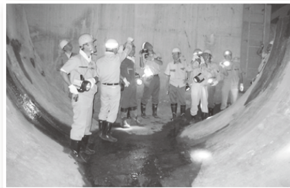
幹線排水路内を視察
