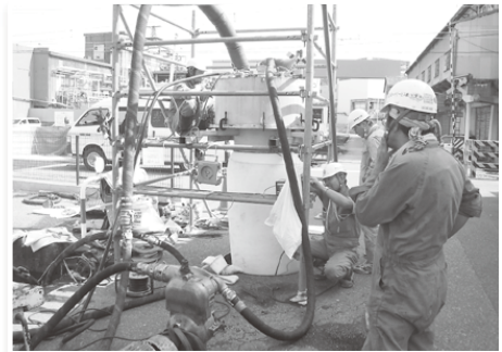
反転工法による管渠更生工事 (2号第5排水路・富士市今泉1丁目地先)
