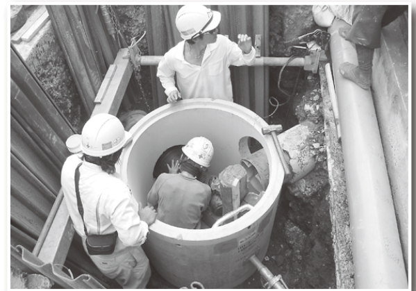
管渠切替工事 (1号第4排水路・富士市久沢地先)
