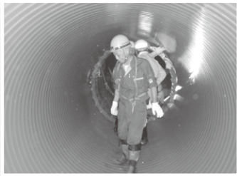
施工中の管内を視察
