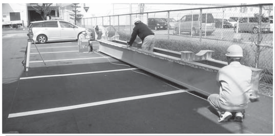
完成した鋼製橋桁の検査
