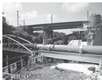
凡夫川水管橋耐震補強工事施工状況(富士市久沢1丁目地先)
