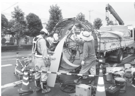
製管工法による管渠更生材搬入状況 (岳南3号第4排水路・富士市今泉地先)
