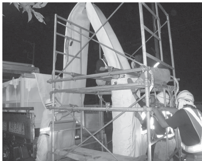
反転工法による管渠更生工事 夜間工事により施工 (岳南1号第5排水路・富士市荒田島町地先)
