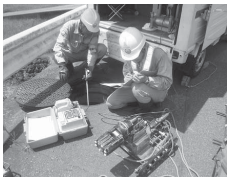
管内点検作業に伴う酸素濃度測定 (富士宮市小泉地先)
