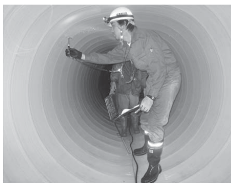
製管工法による管渠更生工事完成状況 (岳南3号第4排水路・富士市今泉地先)
