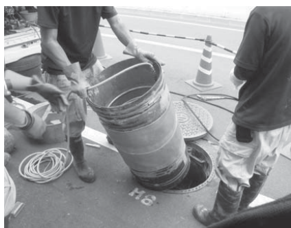
補修材を管内へ挿入
