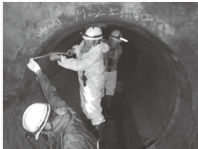
管内作業状況 (平成24年度)
