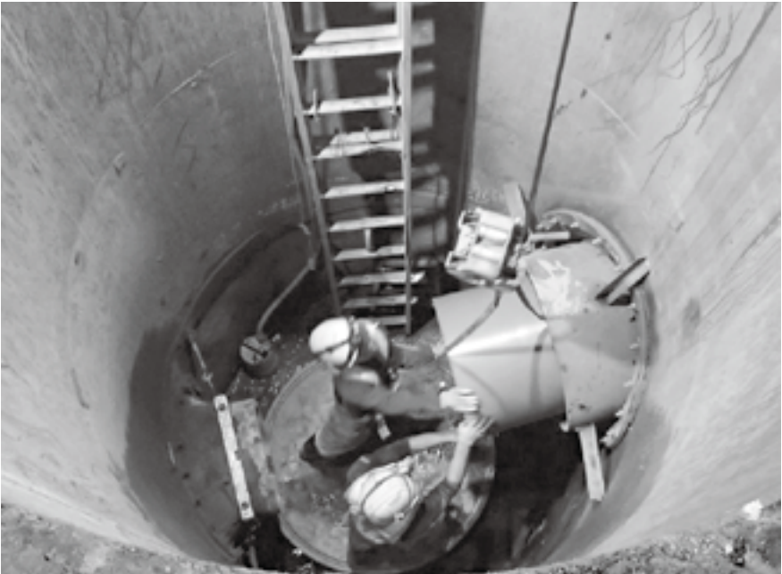
新管と既設管の接続状況 (岳南1号第1排水路 富士宮市浅間町地先)
