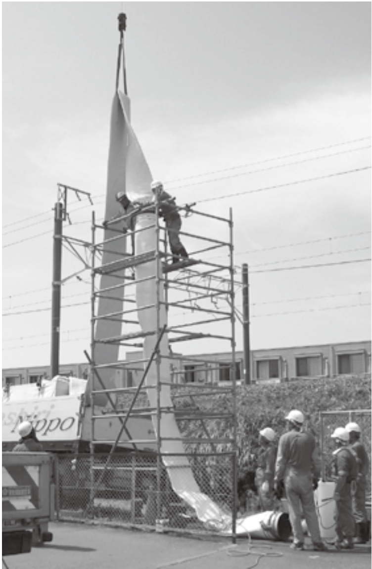
反転工法による管渠更生工事 更生材挿入状況 (岳南1号第4排水路 富士市久沢地先)
