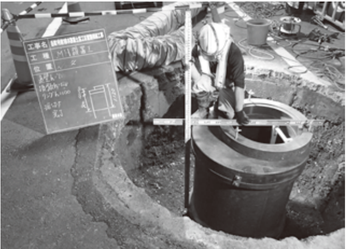
マンホール設置の状況
