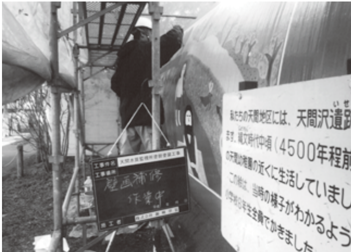
塗替え作業中の状況
