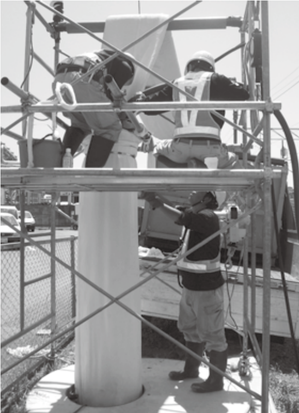
岳南1号第4排水路管渠更生工事（反転工法） 管内への更生材挿入状況
