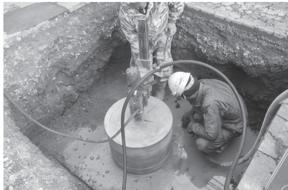
①管に孔を開けているところ
