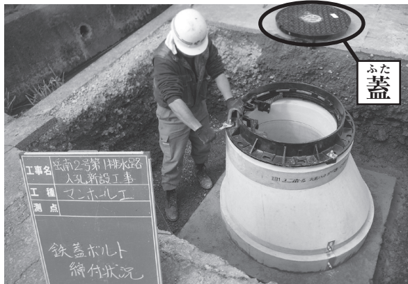
④蓋の受枠を固定しているところ
