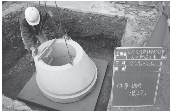
③マンホールを組み立てているところ
