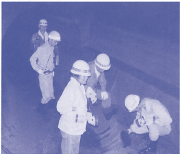
夏季点検時の1号分排水路内の議員視察
