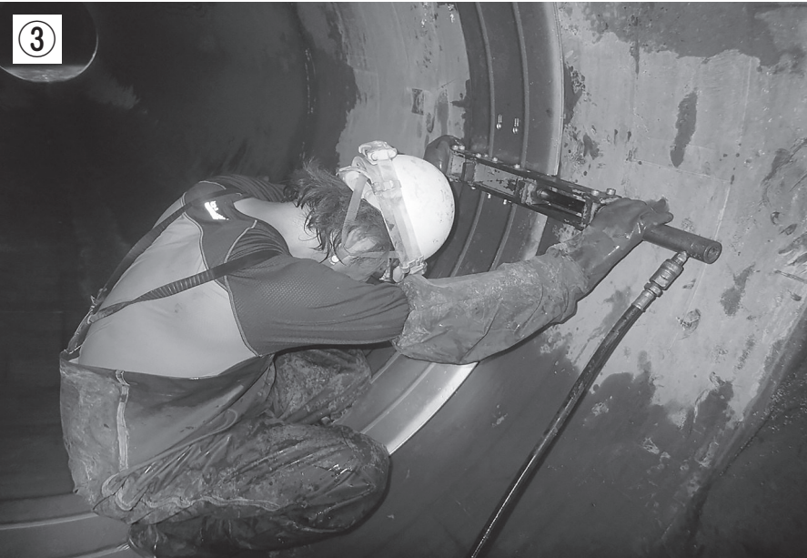
ステンレススリーブを設置しているところ
