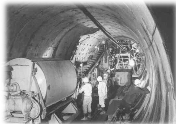
昭和 45 年 岳南幹線排水路シールド工事
